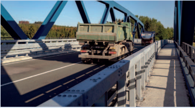
Bild 5: Super-Rail Pro BW (H4b/L4b-W2-B)
