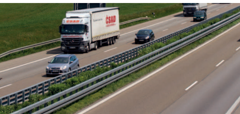
Bild 7: Super-Rail zweifach (H2/L2-W4-A und H4b/L4b-W7-A)
