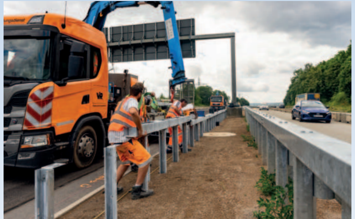
Bild 4: Super-Rail Eco HS (H2/L2-W2-B und H4b/L4b-W4-B)
