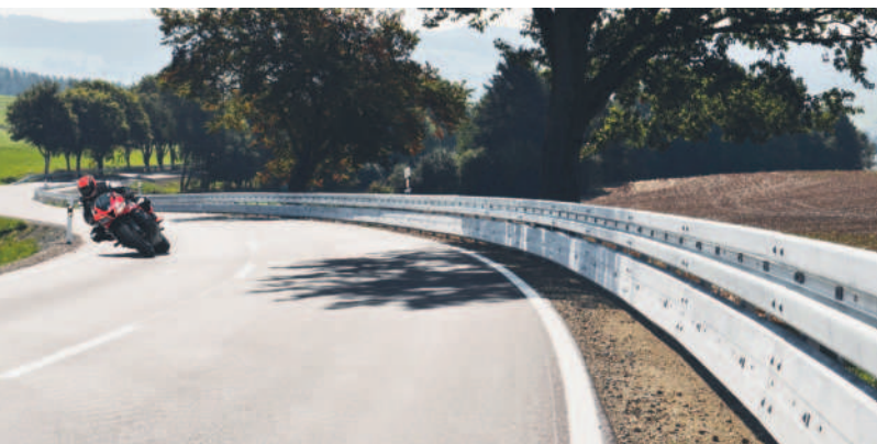
Bild 2: Unterfahrschutz für Zweiradfahrer Eco-Safe MPS (H1/L1-W4-A)
