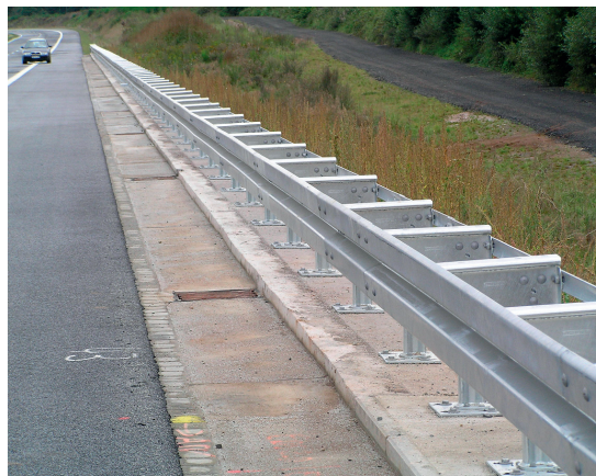
Bild 4: EDSP 1,33 BW auf Fundament in Aufhaltestufe N2 ohne Geländer
