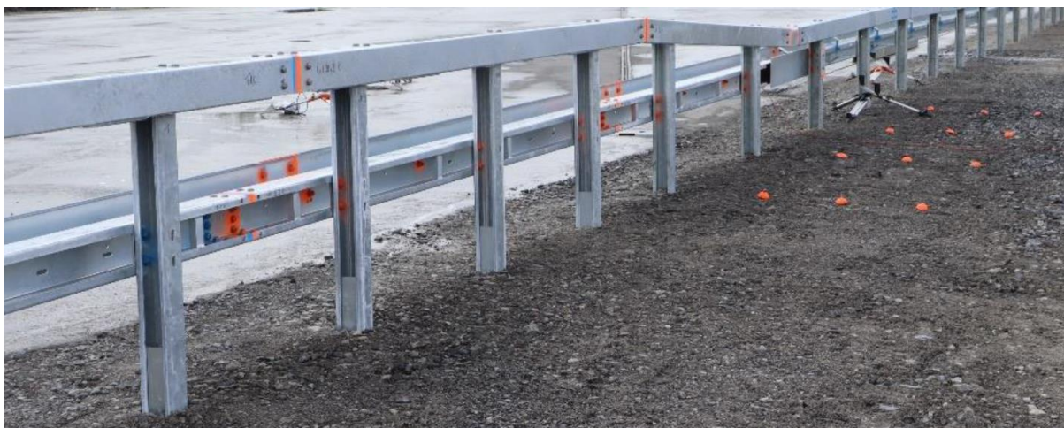
Bild 4: Übergangskonstruktion FLEXTRA SR Eco – SR HS
