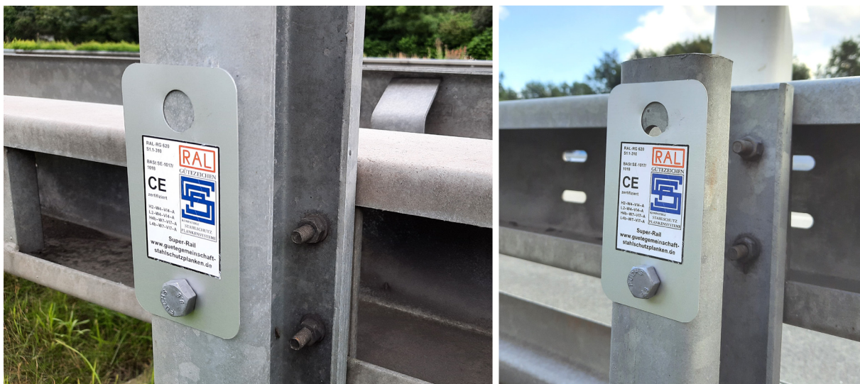
Bild 4: Alternative Kennzeichnung für RAL-Systeme mit Aufklebern auf Trägerplatten
