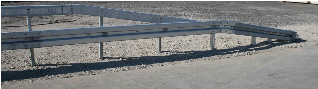
Bild 3: Endkonstruktion Kurzabsenkung SUPER-RAIL (P4D-x1/y1-Z1-B)
