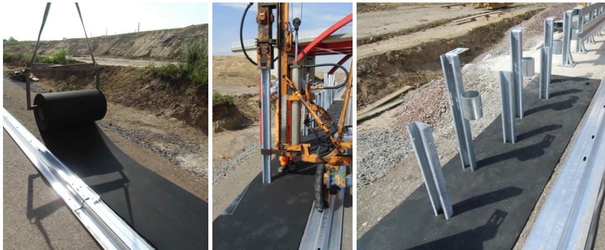
Bild 3: Einbau der bewuchshemmenden Matte und problemlose Pfostenmontage
