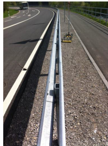
Bild 1: Montierte Eco-Safe-Strecke mit Gleitschutz für Fußgänger und Radfahrer
