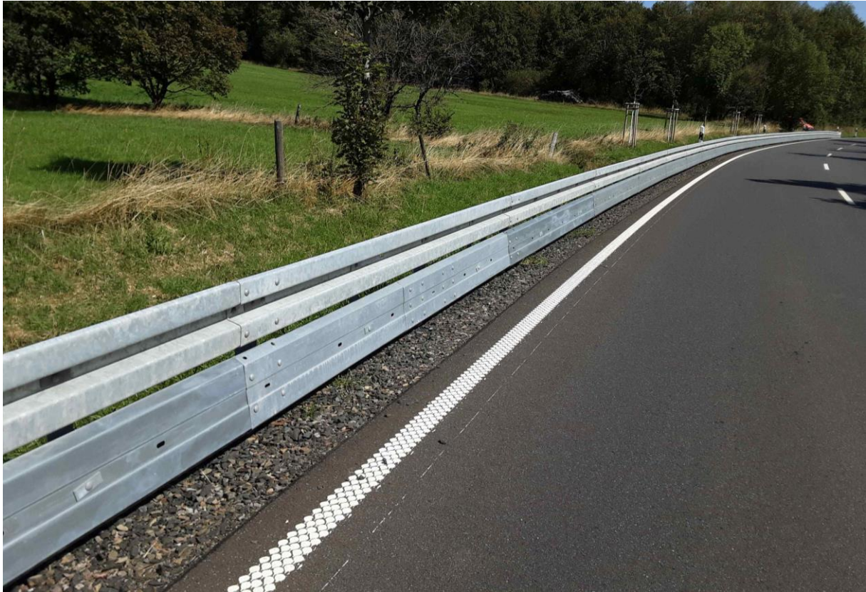
Bild 3: Eco-Safe 2.0 MPS mit eingebautem Dilatationsstoß
