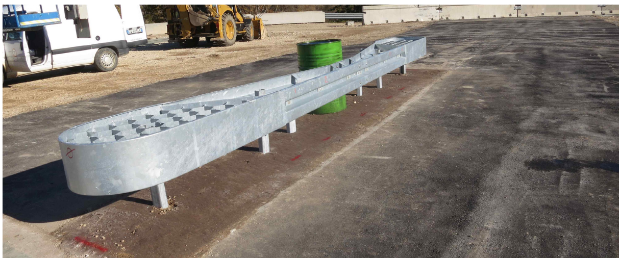
Bild 5: Protector BOS zur Absicherung einzelner massiver Hindernisse
