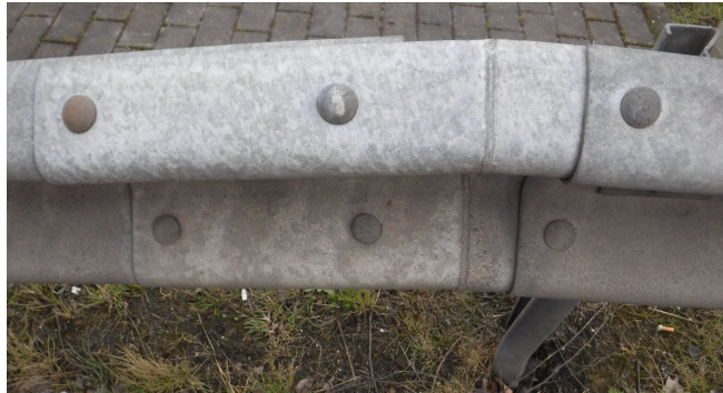
Bild 2: Geschweißter Absenkwinkel Profil A im Bestand
