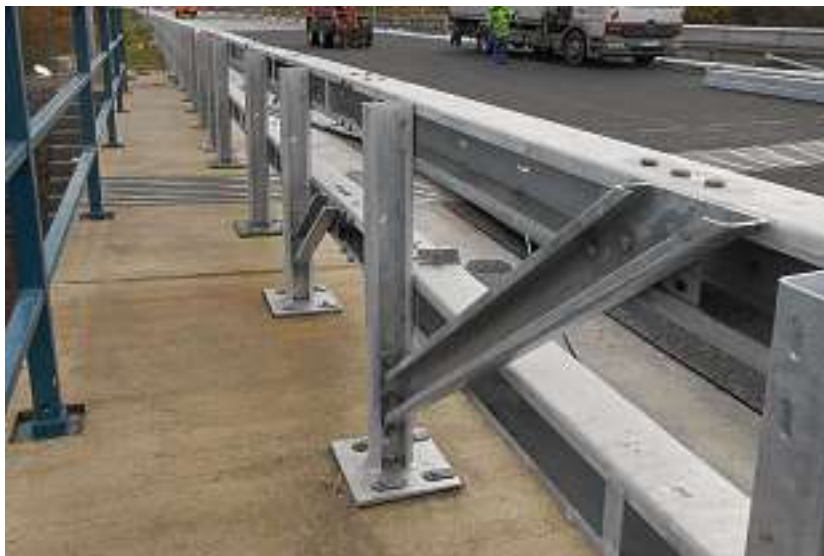
Bild 2: Modifizierte Dilatationsstoßkonstruktion der SUPER-RAIL Bw
