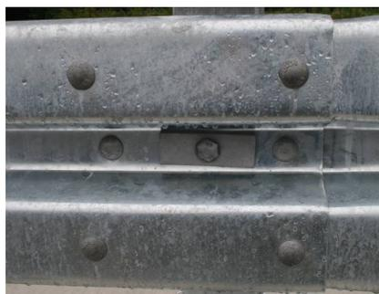
**SP-Holm** mit 1 Stück HRK-Schraube M16x45, Güte 8.8 mit Mutter (40.04) und U-Scheibe 18 (40.30) sowie einer Decklasche für M16 unter dem Schraubenkopf an dem Deforohr (60.17) **befestigen**.
