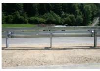
Kastenprofilstoß und Schutzplankenstoß zueinander versetzt. Rechter FBR: 1,10 m Linker FBR: 0,90 m Kastenprofil **rechts** vom Schutzplankenstoß.
