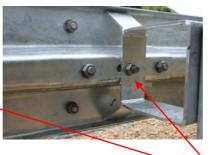
B-Profil: 6 Stück HRK-Schraube mit Nase M 16x27, Güte 4.6 mit Mutter (40.00) und U-Scheibe 18 (40.30) A-Profil: 8 Stück HRK-Schraube mit Nase M 16x27, Güte 4.6 mit Mutter (40.00) und U-Scheibe 18 (40.30)
