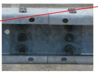
Stoßverbinder 25.02 mit 16 Stück HRK-Schraube M 16x30, Güte 8.8 mit Mutter (40.03) und U-Scheibe 18 (40.30)
