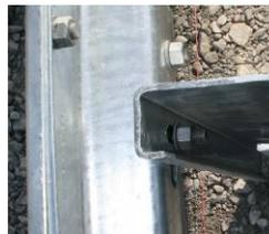
Alle Verschraubungen der Holme mit Pfosten bzw. Deformationselementen: 1 HRK-Schraube mit Sechskant M 16x45, Güte 8.8 mit Mutter (40.04) und U-Scheibe 18 (40.30) sowie einer Decklasche (10.00) unter dem Schraubenkopf.
