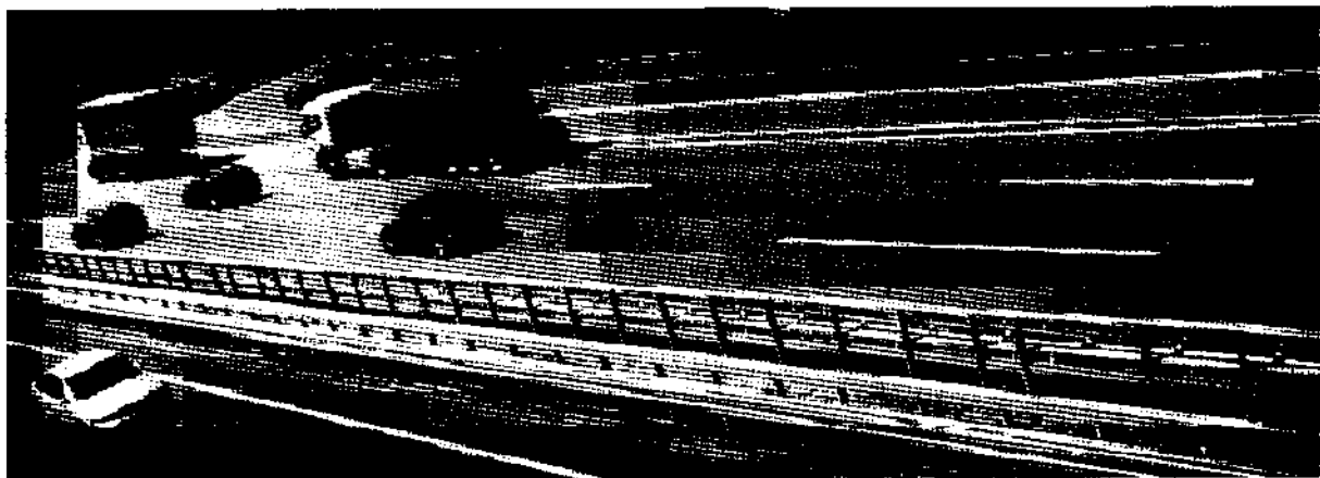
SUPER-RAIL auf beiden Richtungsfahrbahnen im Mittelstreifen der BAB A3
